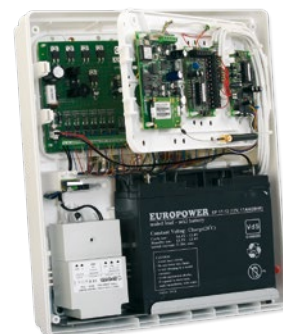
Примеры установки оборудования
